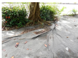
写真-4 樹木の過大な成長に伴う根上がり
